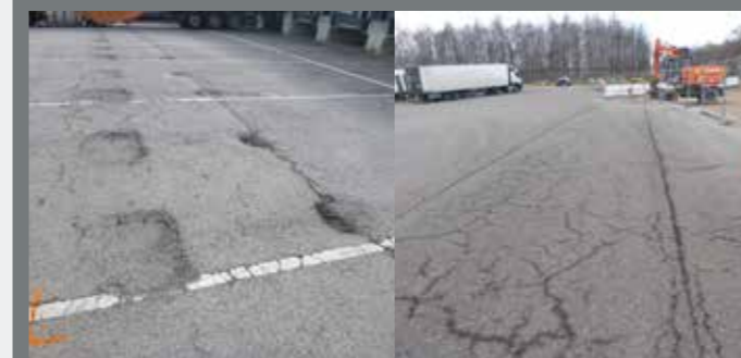
Begutachtung von Schäden an Asphaltflächen & Ermittlung von Spurrillen, Absenkungen und Aufwölbungen
