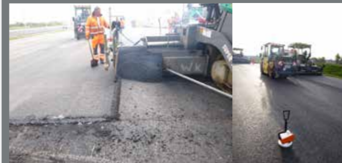
Einbaukontrolle Asphalt, Zerstörungsfreie Verdichtungskontrolle
